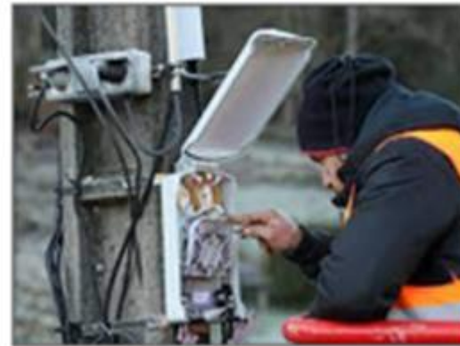
POINT DE BRANCHEMENT OPTIQUE (PBO)
